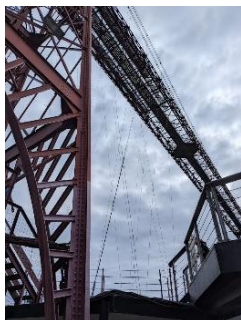
地上から見た ビスカヤ橋
